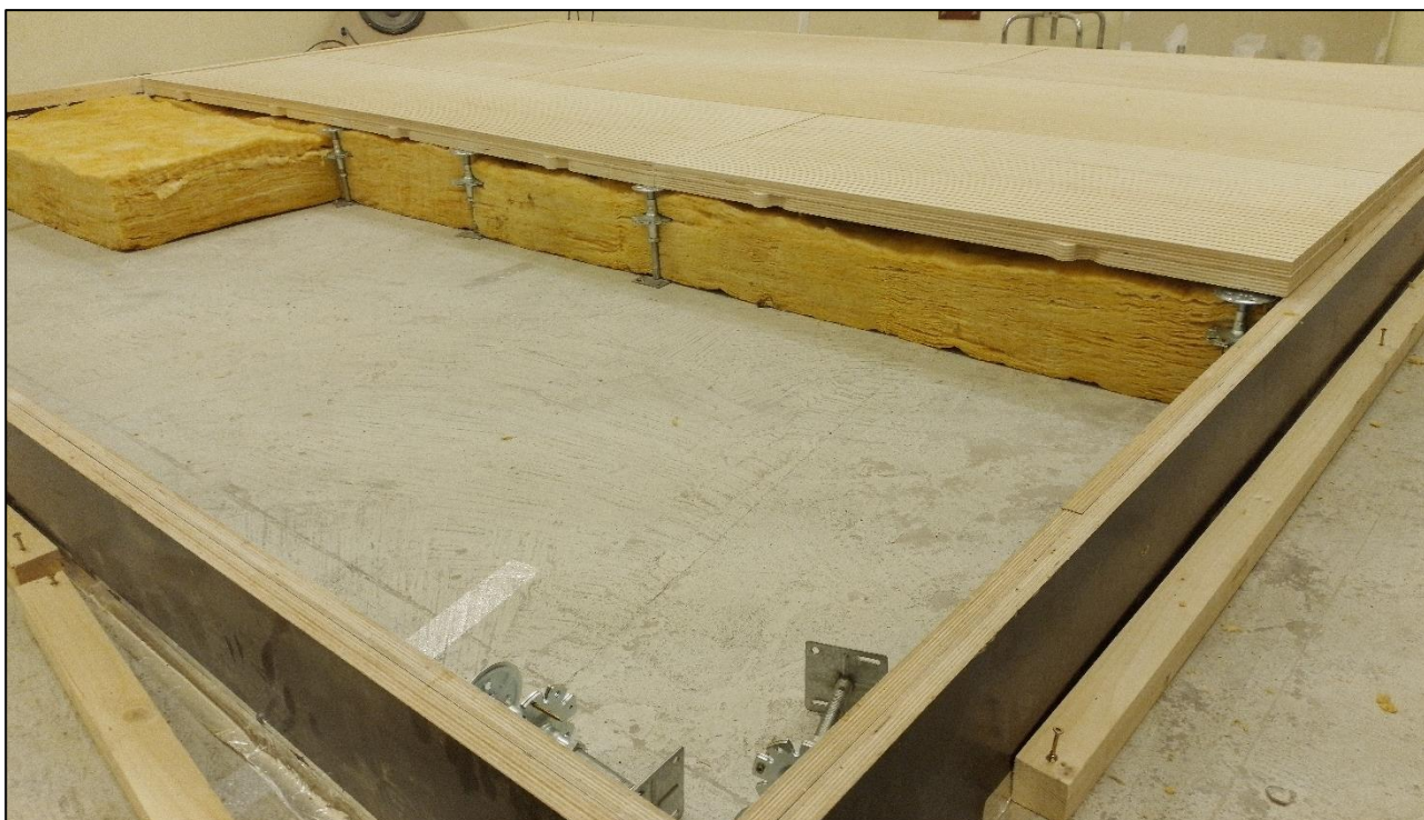
Mise en œuvre de l'ossature, de l'isolant et des panneaux perforés
