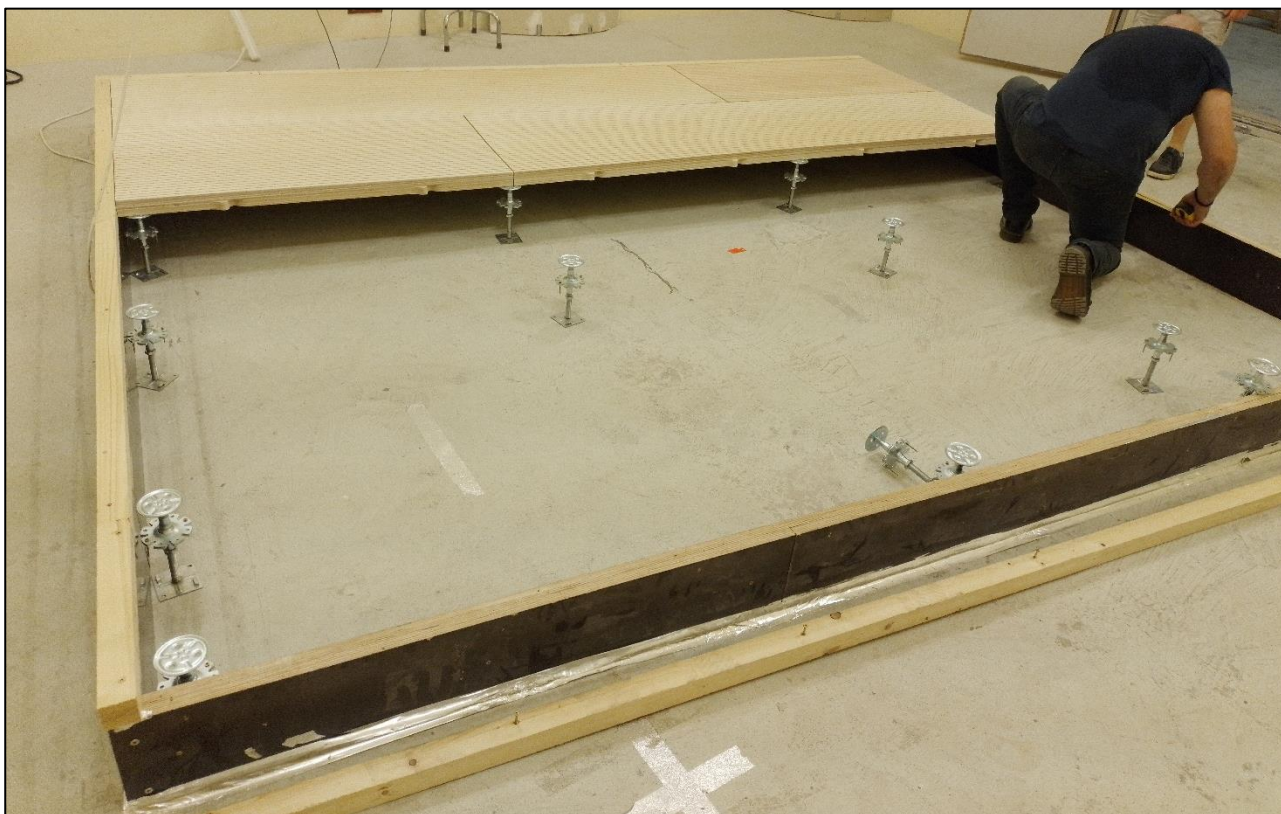
Mise en œuvre de l'ossature et des panneaux
