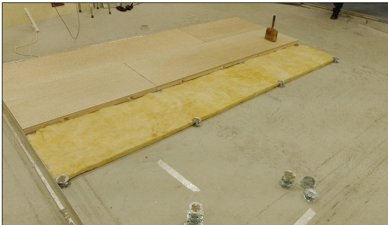
Mise en œuvre de l'ossature et des panneaux
